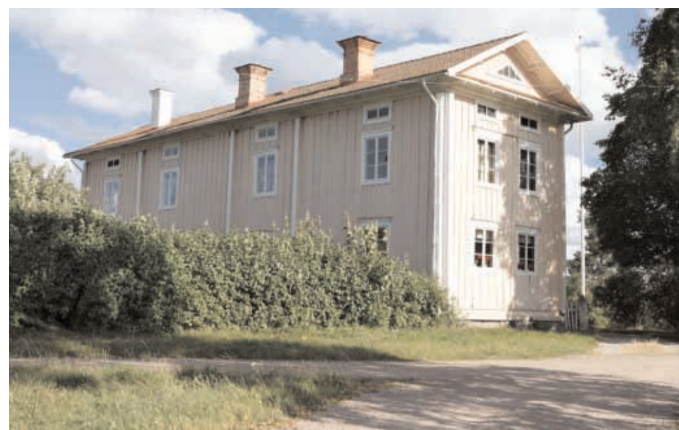
Nygårds äldre mangårdsbyggnad med sin karakteristiska tempelgavel.
